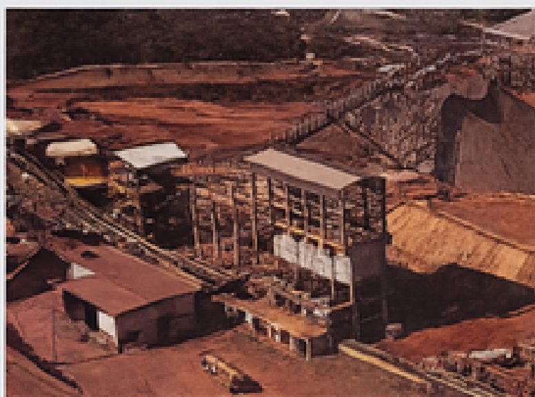
PROJETOS PARA MINERADORAS MAIOR MINERODUTO DO MUNDO | AMERICAN
