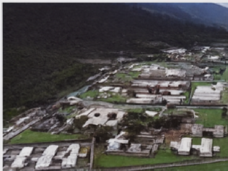
COMPLEXOS PENITENCIARIOS BAURU - RS
